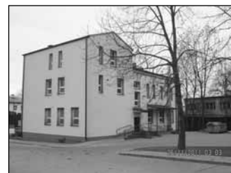
Sierosławice – budynek komory po remoncie – obecnie Szkoła Podst.
