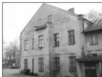
Sierosławice – budynek dawnej rosyjskiej komory celnej
