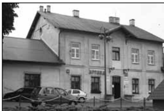
Komora przed remontem – siedziba GOK-u
