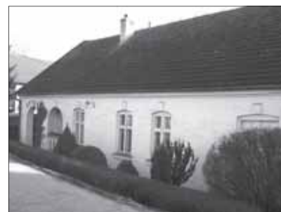
Apteka przed rozbudową piętra
